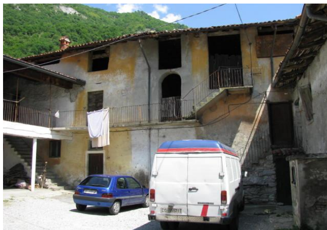
PROSPETTO SU CORTE INTERNA
