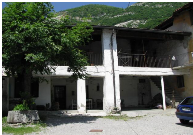
PROSPETTO SU CORTE INTERNA
