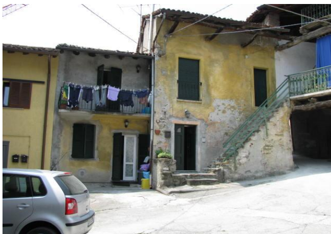
PROSPETTO SU CORTE INTERNA
