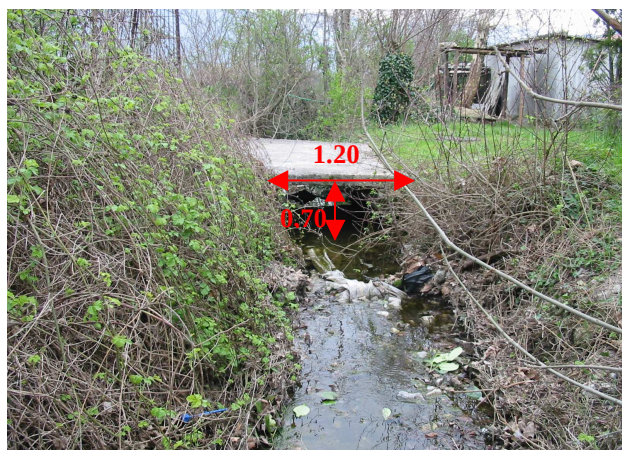
Opera di attraversamento pedonale presente in località Primule a q. 245 m slm circa.
