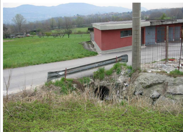
Tratto intubato all'intersezione con la Via Boschetto a quota 236,5 m slm circa (tubo in cls diam 0,80 m)
