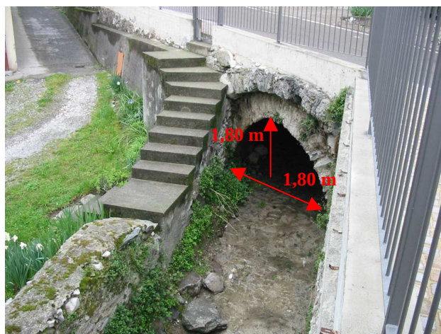
Canale artificiale compreso tra Via Manzoni e Via San Fermo: inghiottitoio all'altezza di Via San Fermo a quota 293,5 m slm circa.
