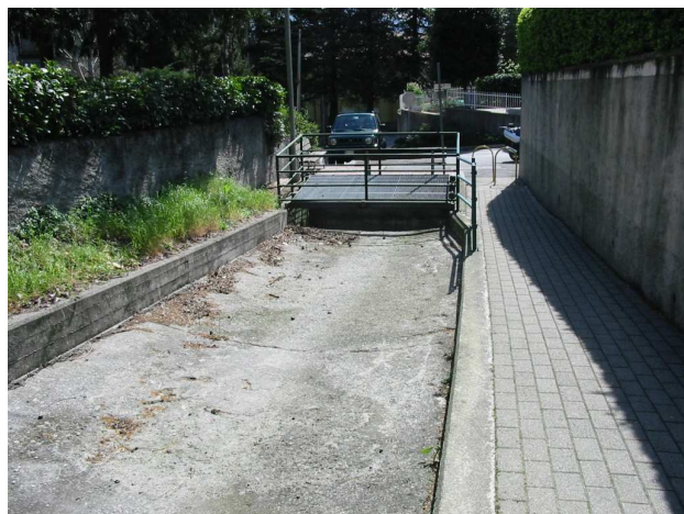
Canale artificiale compreso tra Via Manzoni e Via San Fermo: inghiottitoio all'altezza di Via San Fermo a quota 293,5 m slm circa.
